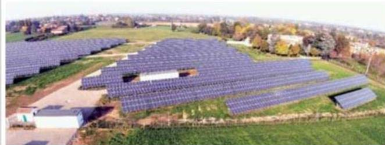
Il campo è stato realizzato da cinque società: Spazio Energia, Sogemont, FinPoker, EnerPoint e lo studio tecnico Torricelli
